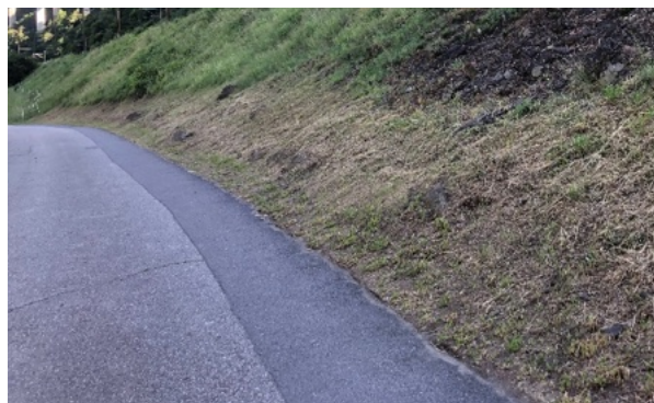
Area verde stradale priva di strutture, sfalciata a filo del suolo (Oikos Sagl)
